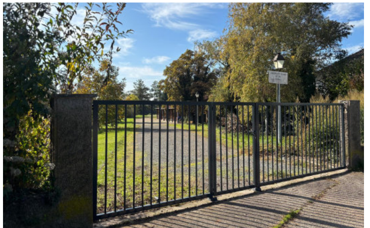
Remplacement du portail de l'étang de pêche (entrée piétons).
