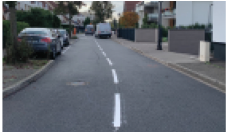
Nouvel enrobé rue de l'étang.
