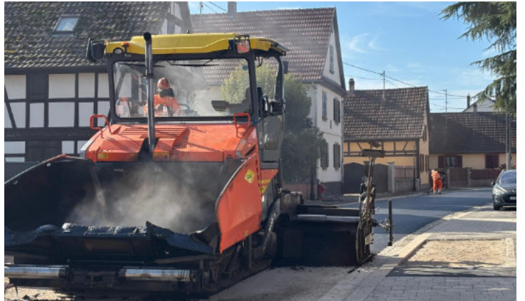
Dernière tranche des travaux de voirie, rue du Gal de Gaulle.
