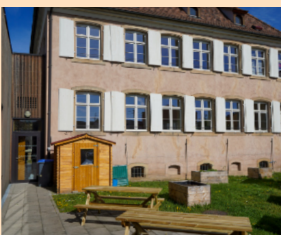
Un nouveau coin détente à l'arrière de la bibliothèque est accessible pendant les heures d'ouverture.
