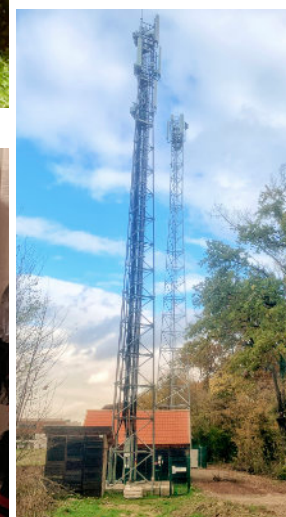
Mise en route de l'antenne SFR
